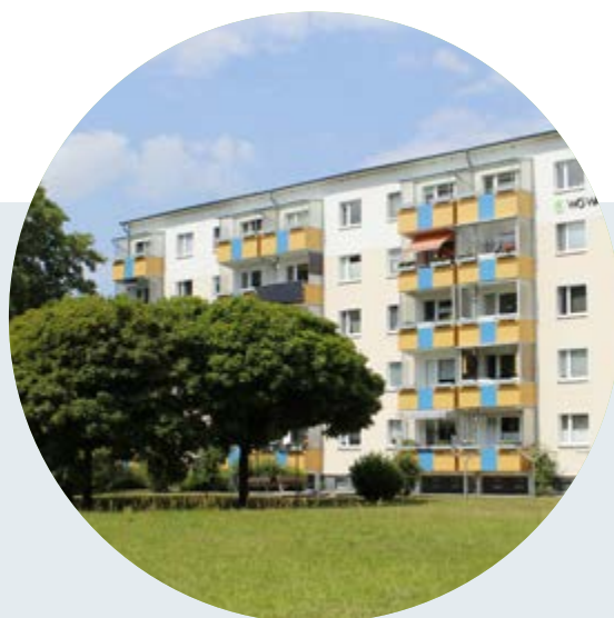
Die Max-Planck-Straße 16 – 20 in der Bauphase und mit der neugestalteten Fassade.
